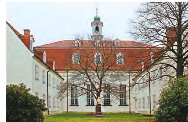
Herrnhut, Kirchensaal. Der zum Zinzendorfplatz gerichtete Flügel wurde 1945 zerstört
