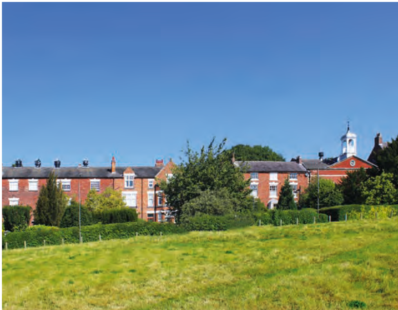
Ockbrook, Häuser an der Settlement Road
